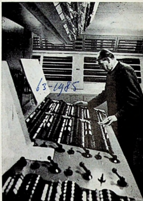
De belichter of lichttechnicus zorgt voor meer dan 500 aangesloten schijnwerpers en „dirigeert” deze installatie volgens een nauwkeurig samengestelde „partituur”.
